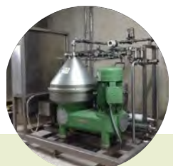
INSTALLATION D'UNE SECONDE CENTRIFUGEUSE 2022 - Romagne
