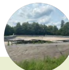
NOUVELLE CONFIGURATION STATION D'ÉPURATION AVEC LA CUMA DE L'ENGRANNE 2023 - Rauzan
